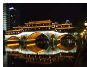
ライトアップされた安順廊橋
